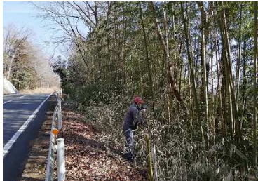
沿道の危険樹木の伐採作業
